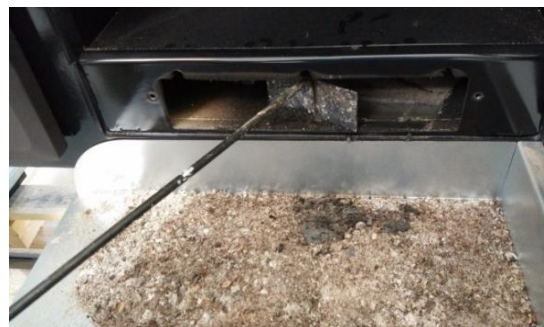
Figura n°21 - Accès pour le nettoyage de la sortie de fumée
