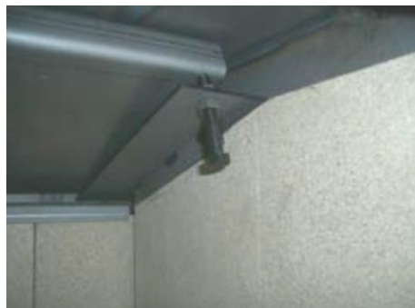
Montage de la vis de réglage
